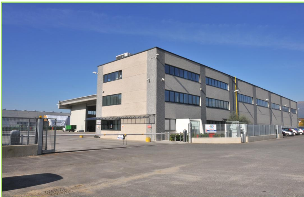
Figura 1 - Immagine dell'impianto di Lurago d'Erba: ingresso carraio
